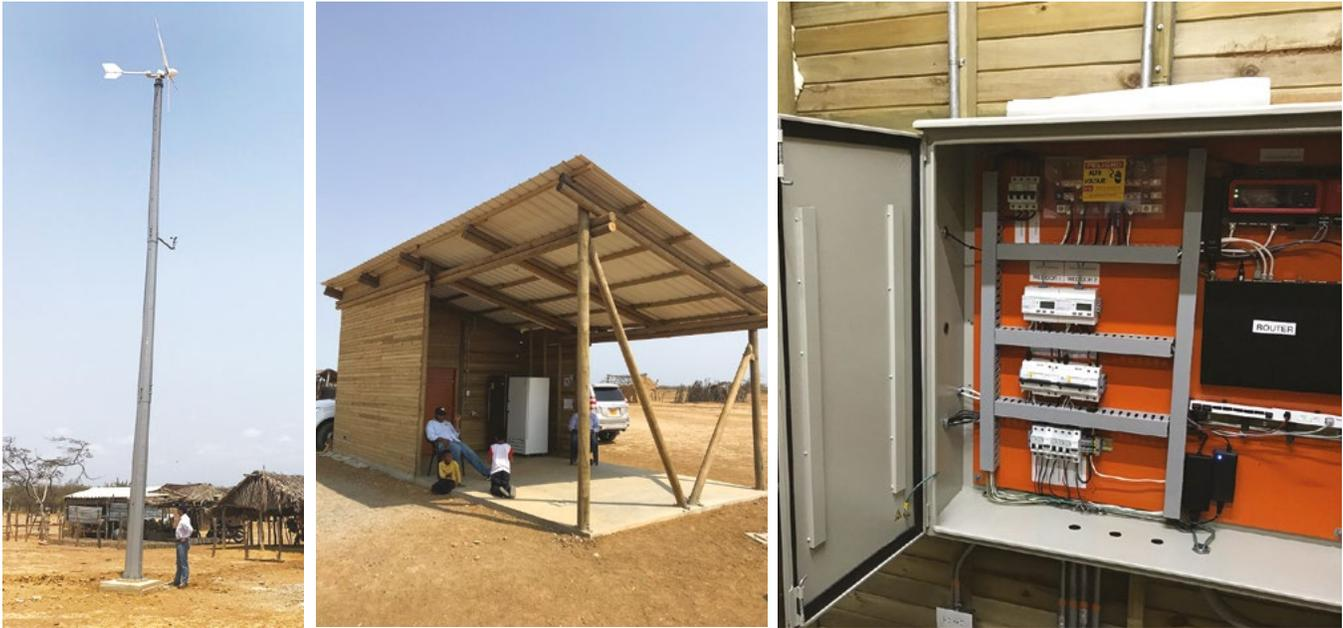
La implementación del sistema se puede ver en la Figura 8, donde se ve el aerogenerador, la enramada con los paneles solares, nevera y refrigerador, así como una visión de dónde y cómo llega la información de los elementos.
