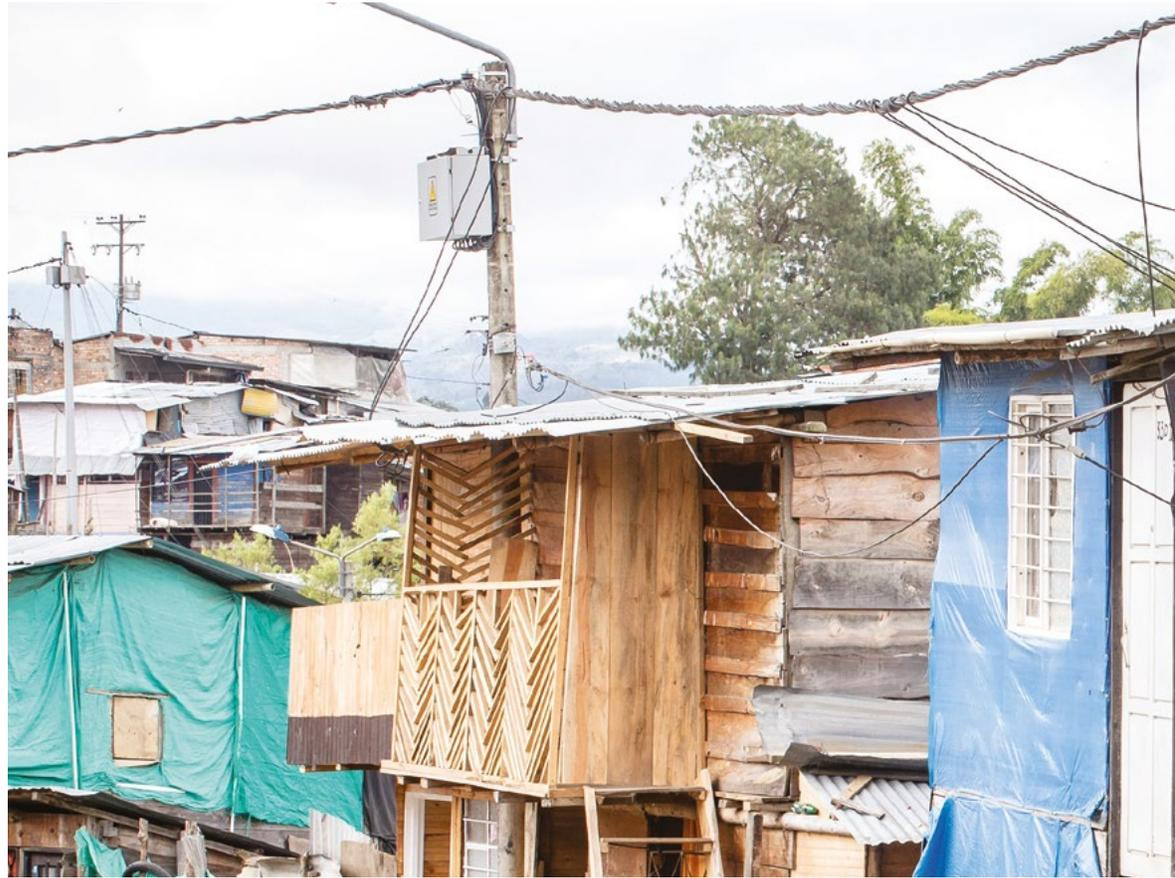
La obra implicó la instalación de postes, redes trenzadas seguras y amigables con el medio ambiente, transformadores autoprotegidos, medidores inteligentes, acometidas y demás materiales que permitieron la prestación del servicio.
